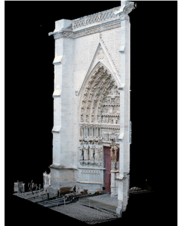
Numerisation 3D du portail sud de la cathédrale d'Amiens (Lab. MIS, programme E-cathédrale)
